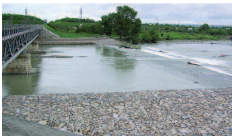
Укрепление насыпи железной дороги
