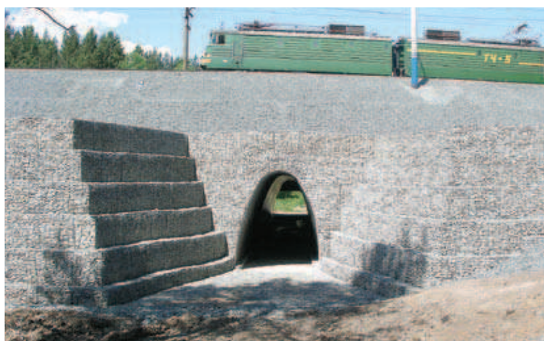
Укрепление насыпи железной дороги
