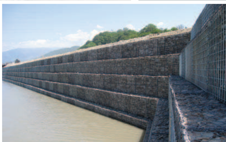
Закрепление высокого берега
