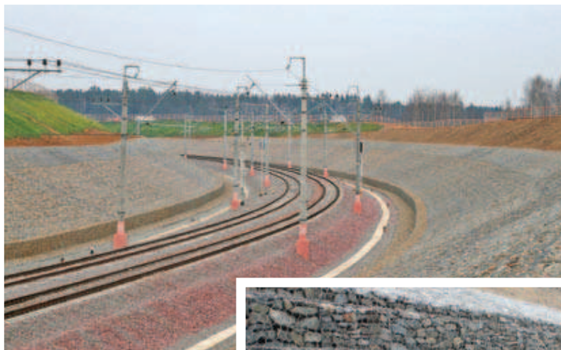
Закрепление откосов выемки
