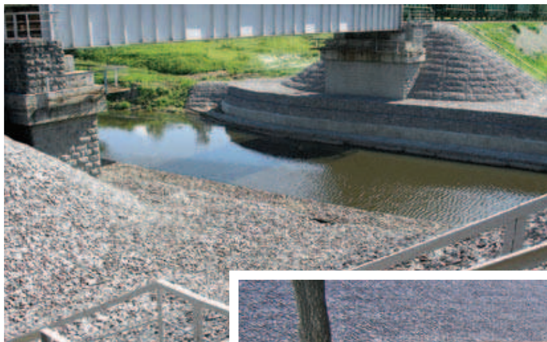
Закрепление конусов моста
