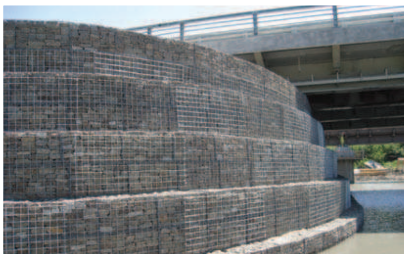
Укрепление высокого берега
