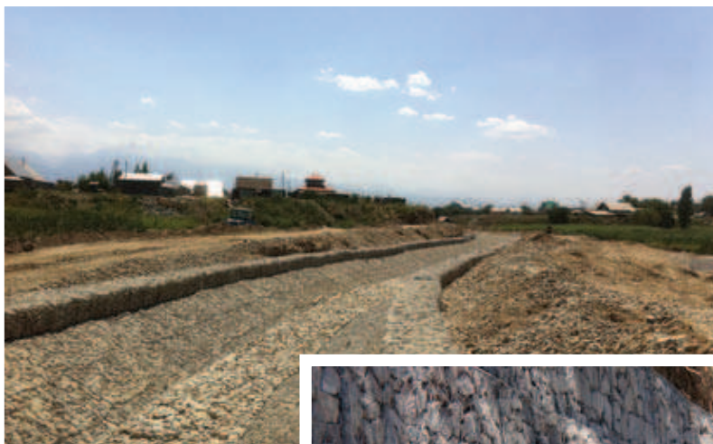
Укрепление русла оросительного канала
