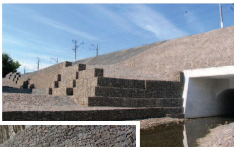
Укрепление насыпи железной дороги
